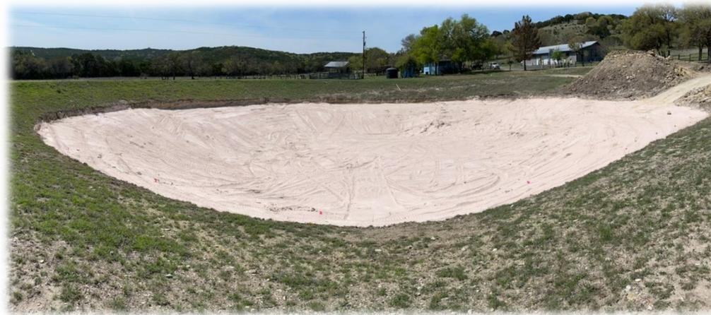
3. Aplicar bentonita y extenderla como una manta uniformemente en la dosis deseada.
