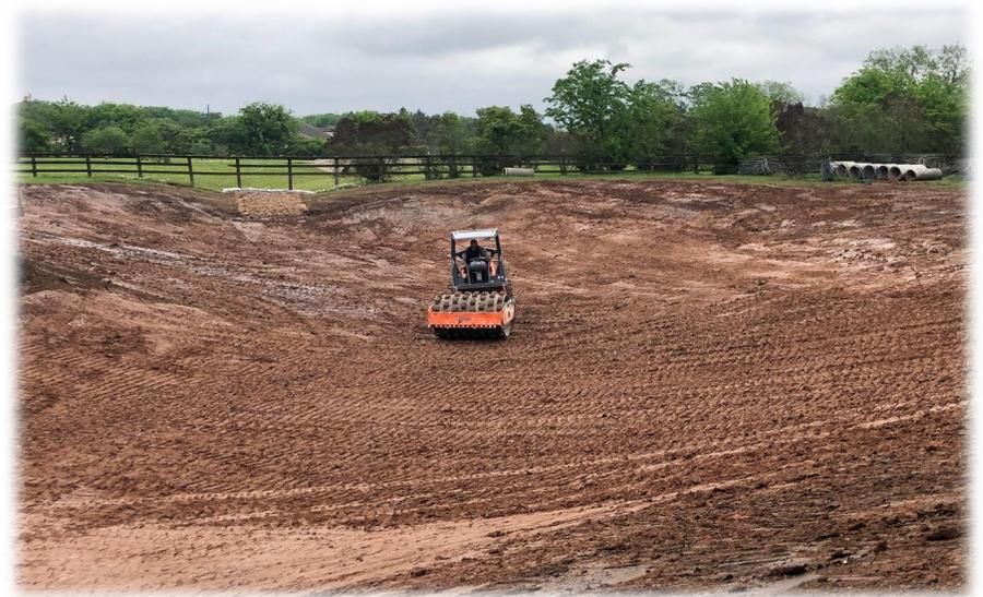
5. Compacte la bentonita utilizando un rodillo de pata de oveja o un rodillo vibratorio.
